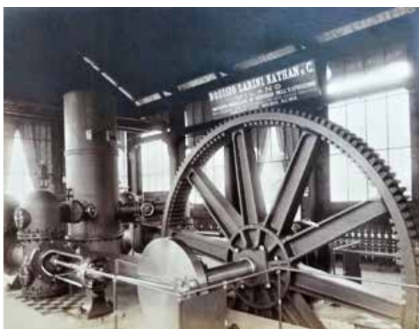
Padiglione con l'impianto idraulico di servizio all'Esposizione, foto all'albumina. Album fotografico con 24 soggetti Esposizione di Torino 1884.
