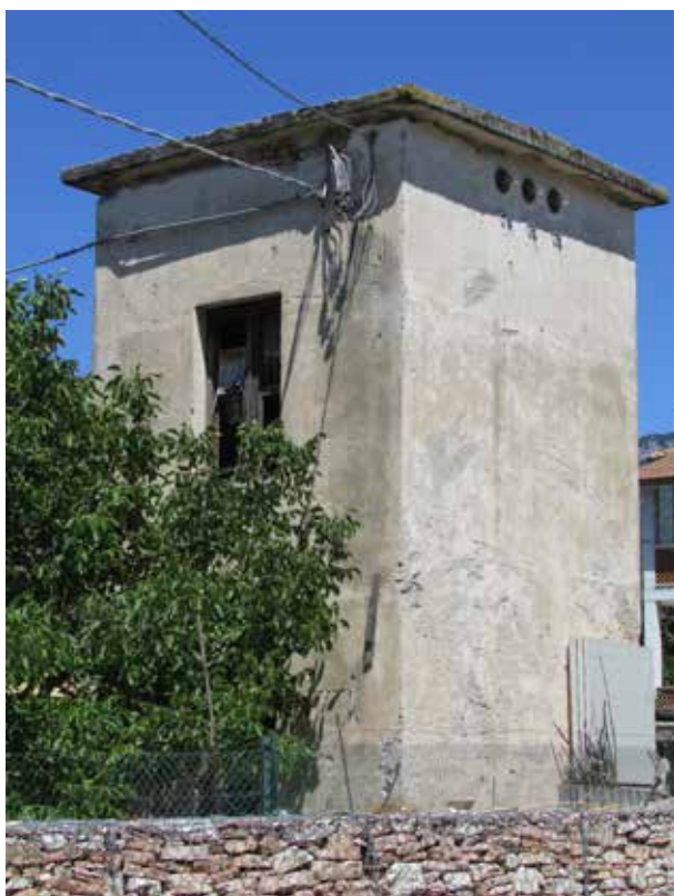
FERENTILLO (TR), vecchia cabina elettrica.
